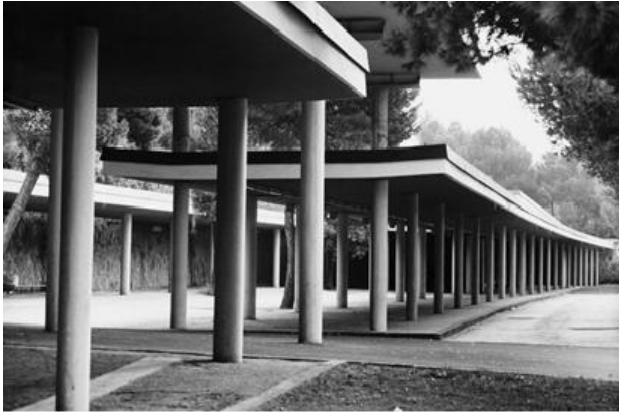
Figura 1: Fabbrica Olivetti a Pozzuoli (Arc. L. Cosenza)
