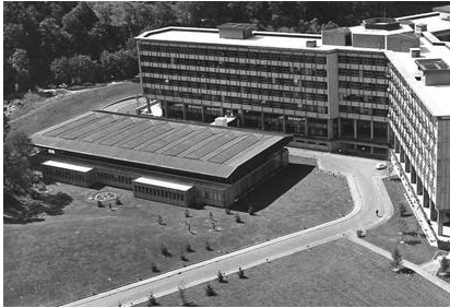
Figura 3:Palazzo Uffici Olivetti a Ivrea:Centro di calcolo(arc. Nizoli ed Oliveri)
